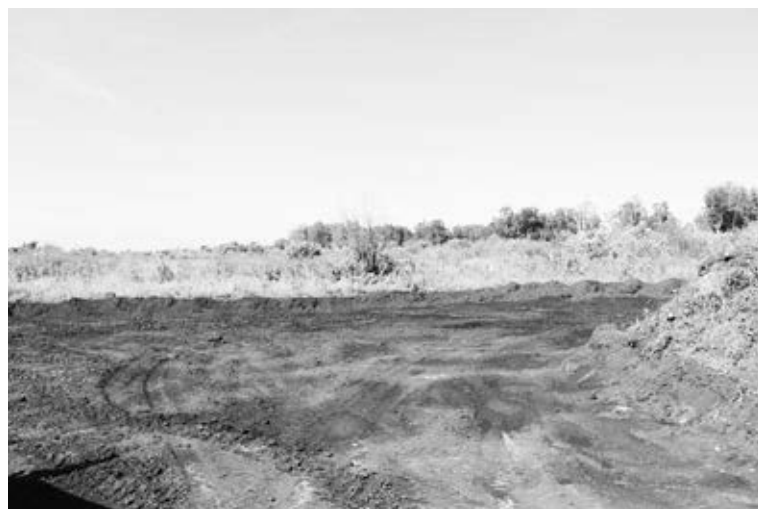
Снятый дёрн на площадке, с которой вывозится плодородный слой.
