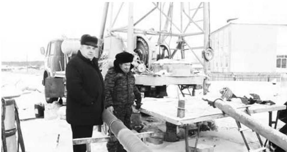
Б. В. КАЛИНИЧЕНКО ЗНАКОМИТСЯ СО СТРОИТЕЛЬСТВОМ ВОДЯНОЙ СКВАЖИНЫ В С. ПИХТОВКА.
